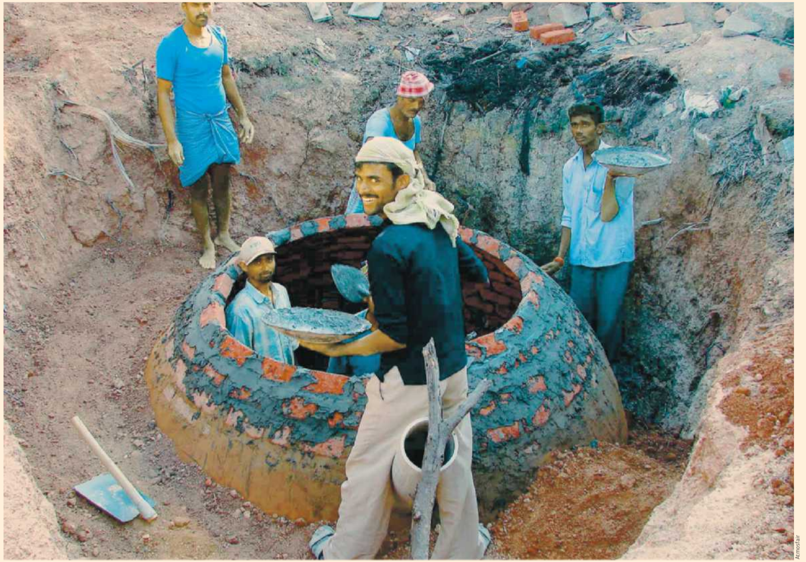
Arbeiter errichten im indischen Staat Karnataka eine Kleinbiogasanlage , die durch Spenden an Atmosfair finanziert wurde
